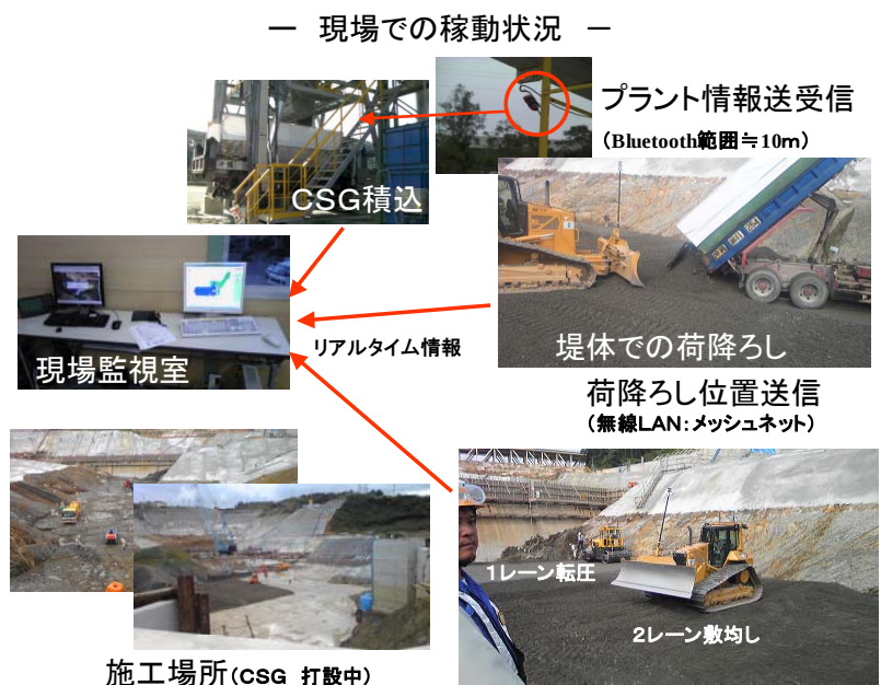
図-4 現場での導入状況
