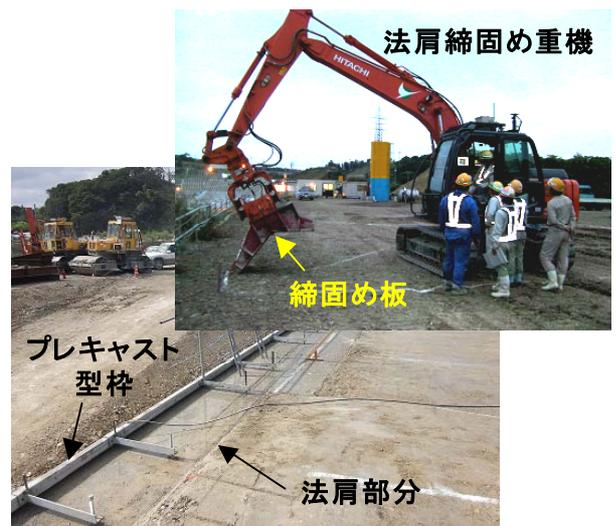
図-6 法肩部と締固め重機
