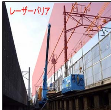
写-2 ハンステージング工法施工状況
