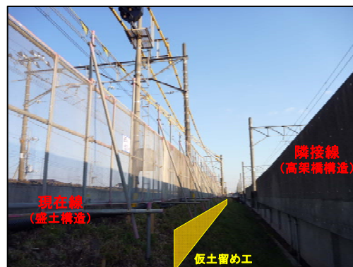
写真－1 営業線近接状況写真
