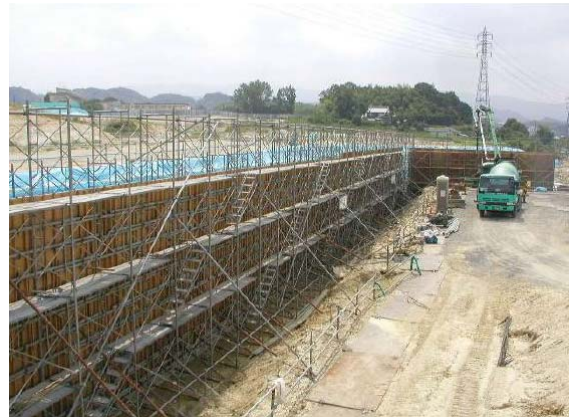
図1 型枠とコンクリート打設
