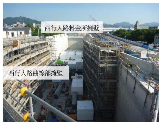
写真-1 料金所街路側擁壁と仮設防音シート
