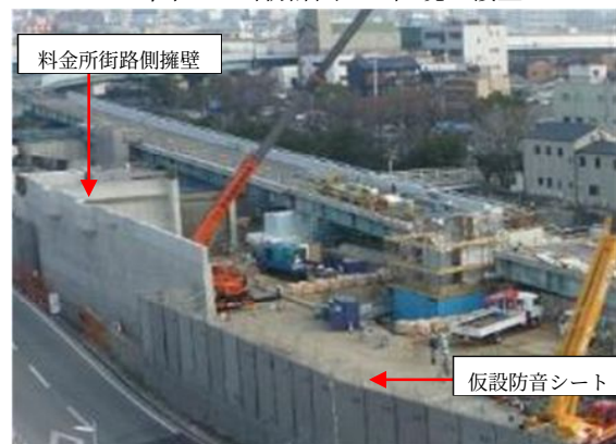
写真-1 料金所街路側擁壁と仮設防音シート
