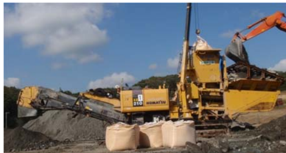
写真-1：不溶化混合処理（自走式土質改良機）
