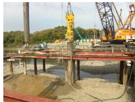
写真-1 ダウンザホール ハンマーによる削孔状況
