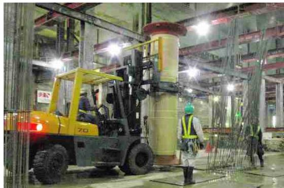
図.2 鋼管柱運搬状況
