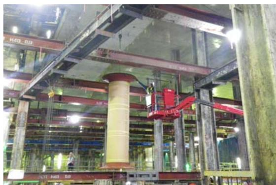
図.3 鋼管柱吊上げ状況
