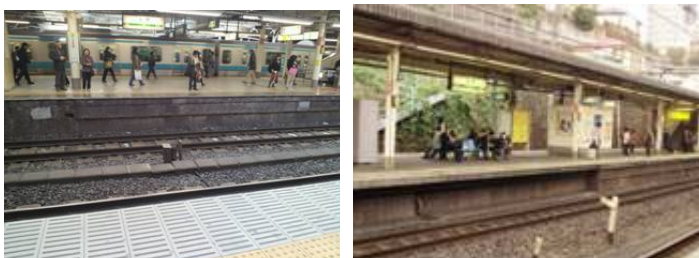
(写真-1)コンクリートブロック積式と鉄筋コンクリート式ホーム
