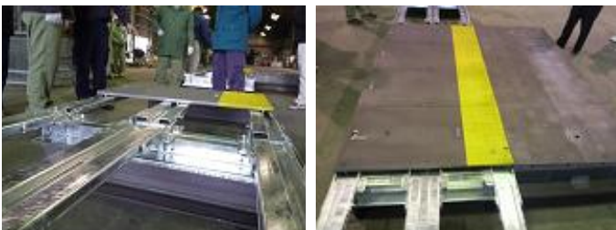
(写真-2)盛土式フレーム材 (写真-3)ホーム側軽量覆工板
