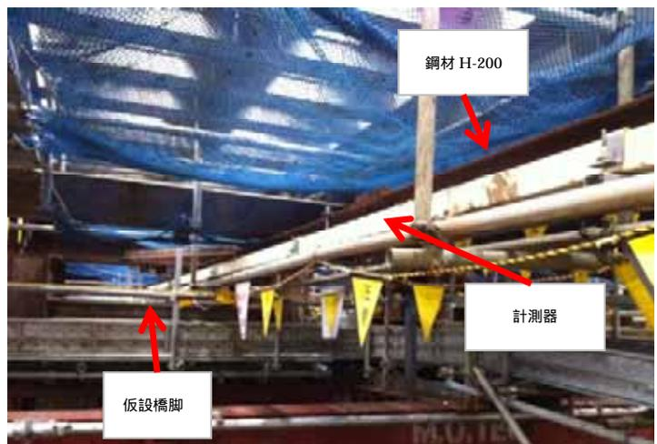
図5. 計測器設置状況
