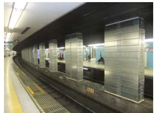
写真-2 工事完了状況
