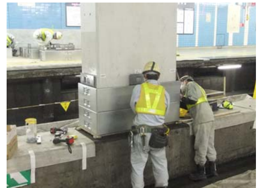
写真-1 施工状況
