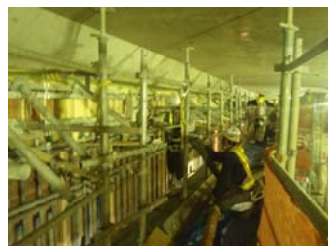
写真-2 打設状況
