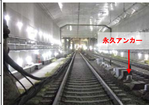
写真 永久アンカー施工完了
