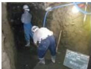
導坑掘削状況
