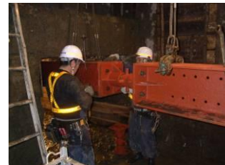
受桁架設状況
