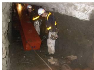
受桁引込状況
