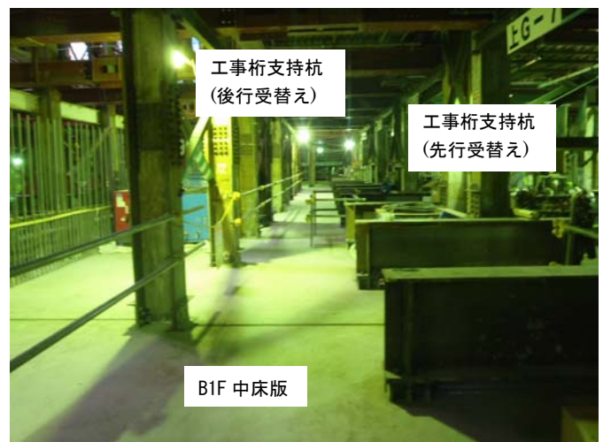
写真-2 B1F 中床版上 支持杭受替え
