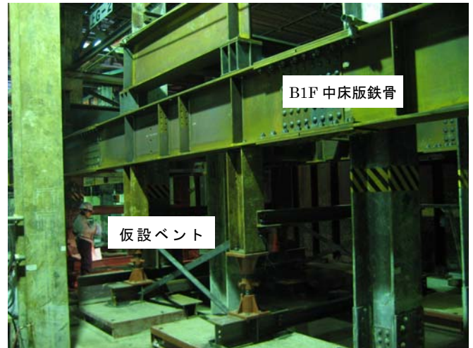
写真-1 仮設ベント材設置状況
