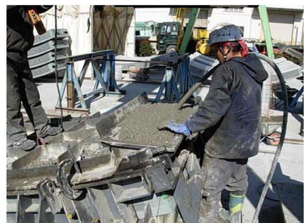
写真-2 継手板部の打設状況
