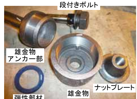
写真-3 改良雄継手の構成部材
