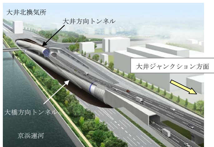
図-1 中央環状品川線大井地区トンネル工事
