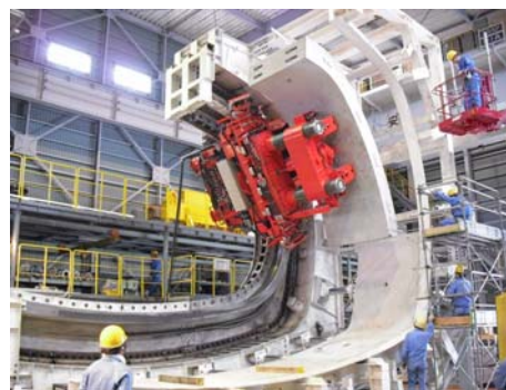
写真-2 セグメント組立状況 (リングの3/8組立)
