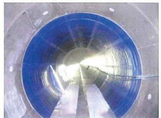
写真-5 完成状況
