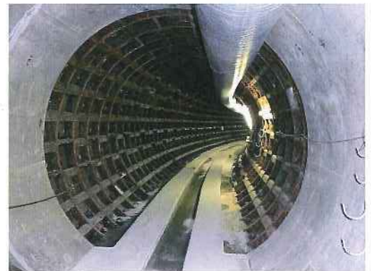
写真-1 3Sセグメント工法施工前
