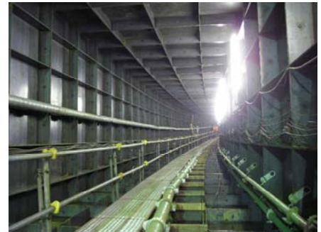
写真-3. 掘削後の鋼殻内
