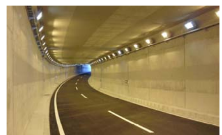
写真-5. トンネル完成状況
