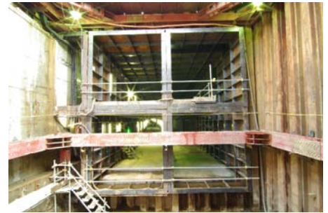
写真-2. ハーモニカ掘削完了後の坑口
