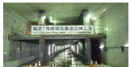
写真-4. 内部構築完了後
