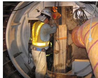
写真-3 支障物引抜き状況
