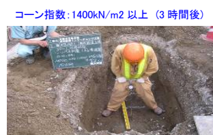
写真-5 改良体確認状況
