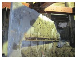
写真-1 谷津干潟旧護岸
