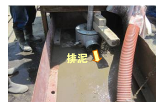
写真-6 排泥回収状況
