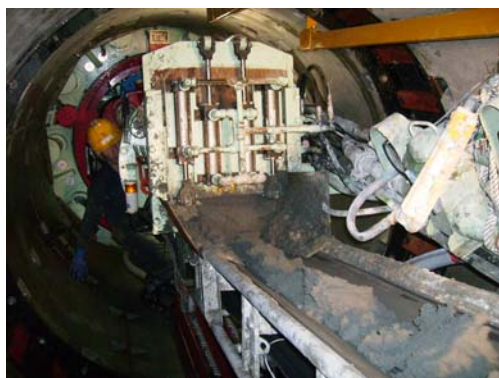
写真-3 排土状況
