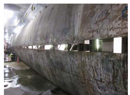
写真-3 中央部ピース撤去完了状況
