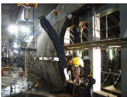
写真-4 上段ピース撤去状況
