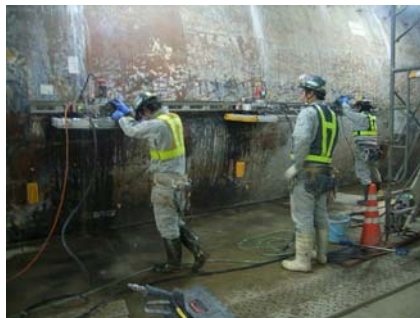
写真-2 ウォールソー切断状況
