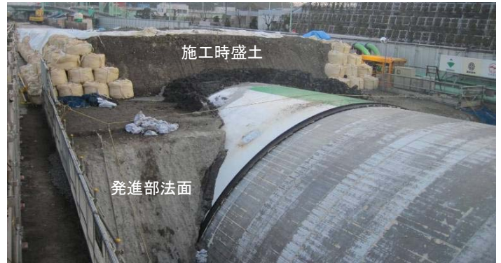
写真－3 地上発進完了
