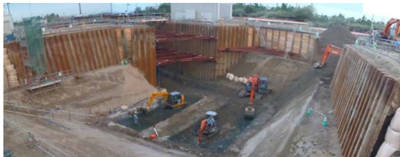
写真-4 掘削完了全景
