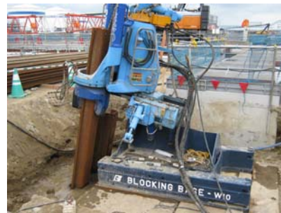
写真-3 反力架台
