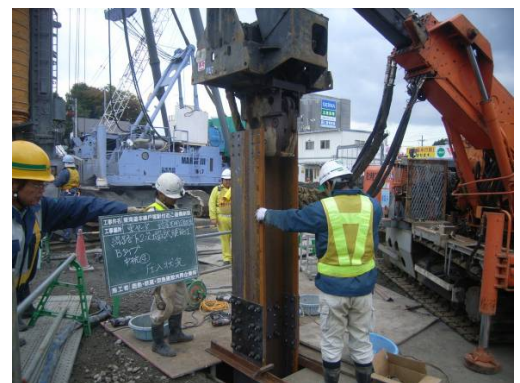
写真-2 施工試験状況（H形鋼挿入時）
