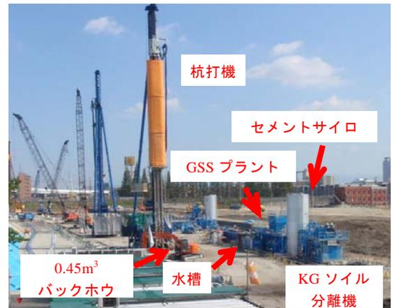
写真-1 SMW 施工配置状況
