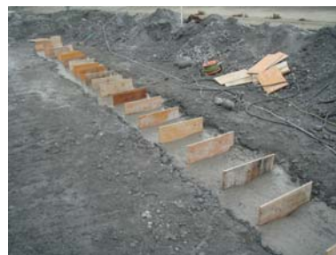
写真-4 締め固め後の状況
