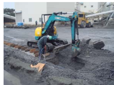
写真-5 小割り実施状況
