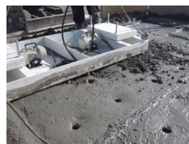
写真-6 振動締め固め状況
