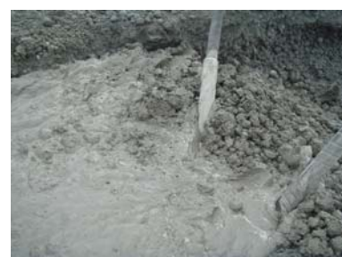
写真-3 締め固め時の状況
