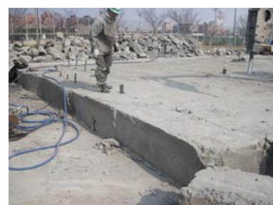
写真-7 小割り実施状況
