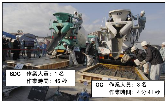
図-7 スラブ状モデル型枠打込み状況
