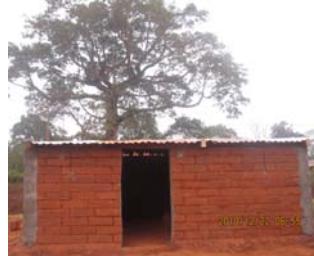
写真5 施工した小屋
