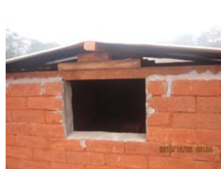
写真9 屋根の取付け
