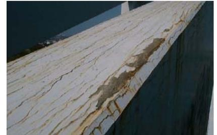
写真 1 ASR を生じた構造物の例
