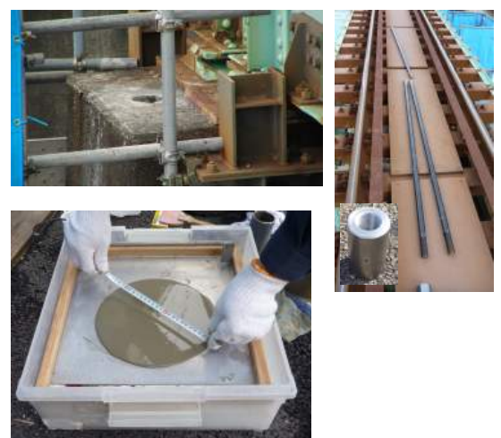
写真-2 橋脚削孔, アンボンド PC マックス AZ
