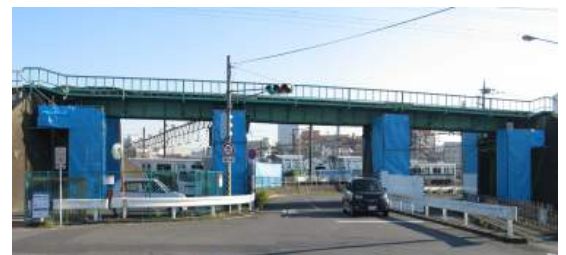
写真-1 施工状況
