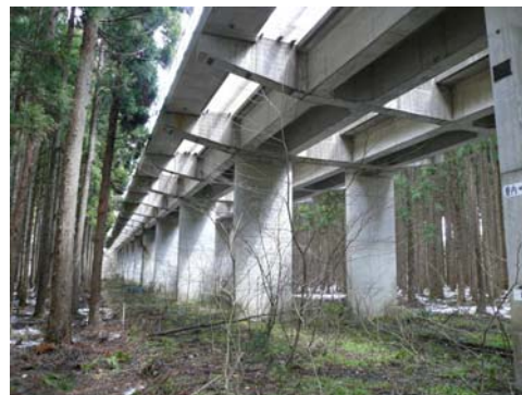
写真-1 12 径間ラーメン高架橋
