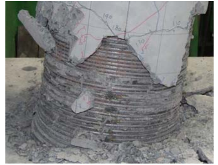
写真-3 損傷状況③ (K5 (20δ y ))
