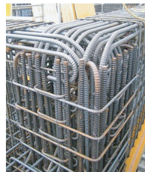
写真-1 配筋状況
