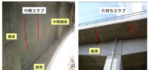
図-1 高架橋スラブのひび割れ例
