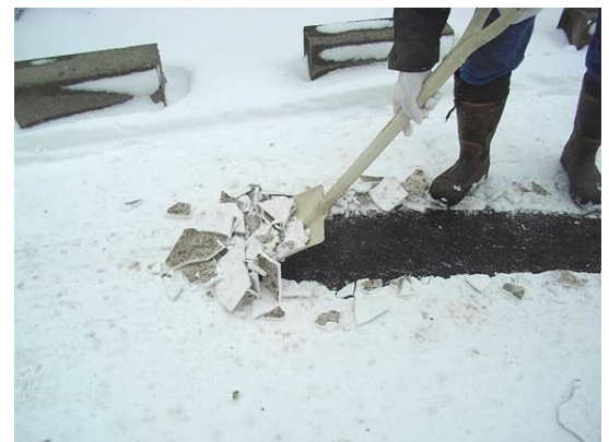
写真 3 スコップによる圧雪の除去
