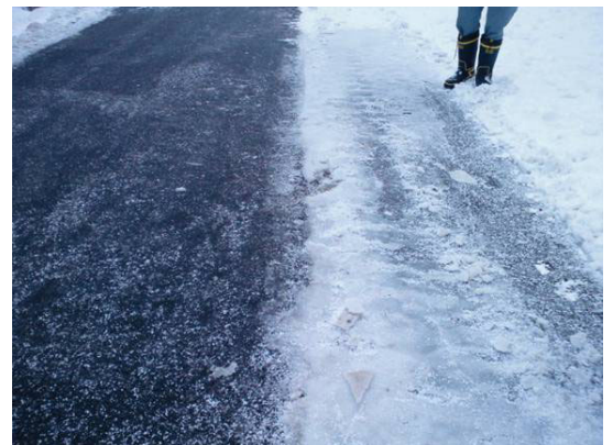
写真 2 タイヤショベルによる除雪後の路面 (左: 氷板破碎舗装, 右: 密粒 13)
