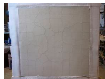
写真-2 加熱後の耐火被覆材
