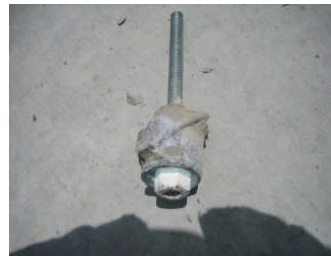
写真-9 突起羽残存状況
