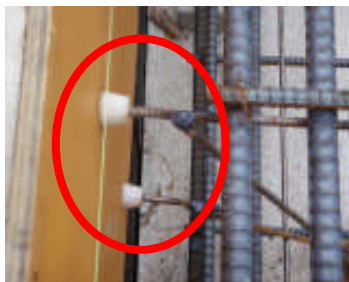
写真-1 型枠固定状況
