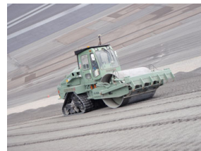
斜面自走式振動ローラによる転圧状況
