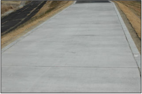
写真-2 供用 1 ヶ月後の供用状況
