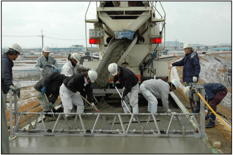
写真-1 施工状況
