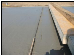
写真-5 目地注入
