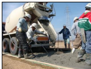
写真-3 荷下ろし
