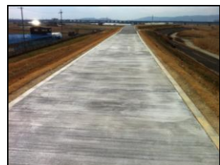
写真-8 完成全景
