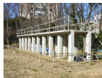
図1 中規模柱試験体(右手前が東)
