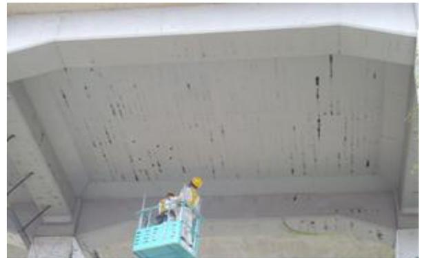
写真-1 D工法の鉄筋に沿った変色
