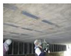
陽極固定金具取付
