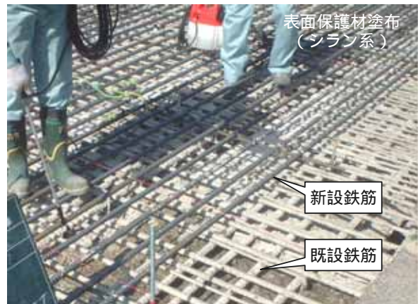
図-1 打継面への表面保護材の塗布状況例
