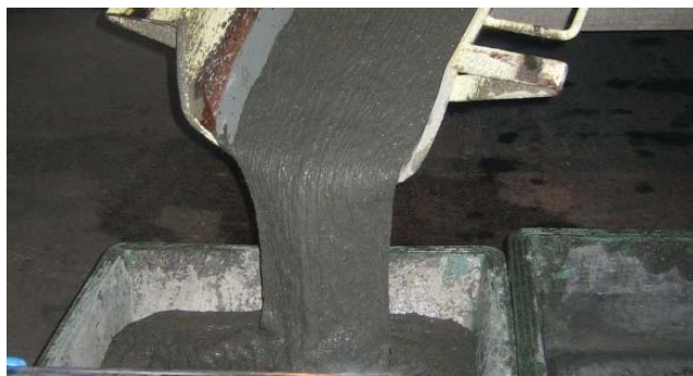
写真-1 アジテータトラックからの排出状況
