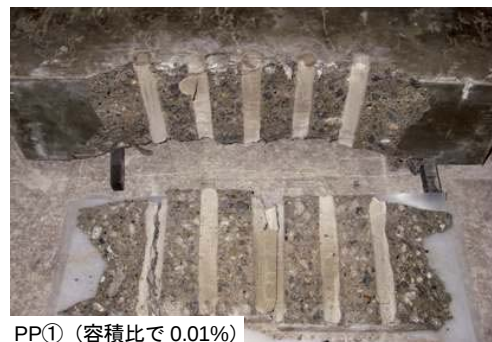
写真-2 打撃試験後のはく落状況の例
