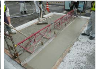
写真-5 t=2cm 工区
