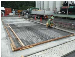
写真-2 型枠設置状況
