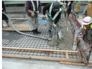
写真-3 打設状況
