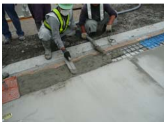
写真-6 人力施工箇所
