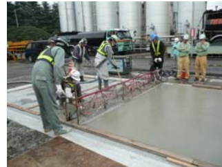
写真-4 t=5cm 工区
